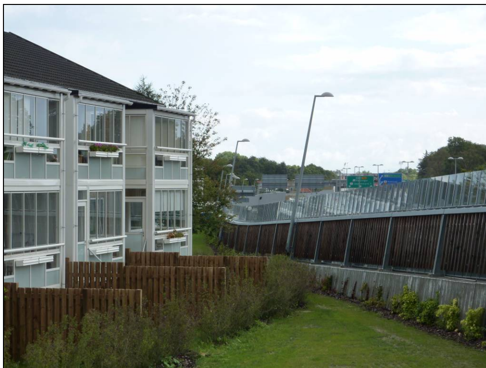
Figur 26. Støjskærme langs motorvej. Det er Vejdirektoratets erfaring, at støjskærme langs motorveje og motortrafikveje har en højere pris end skærme langs andre vejtyper. Vejanlæggets bredde kan også betyde, at skærme langs motorvejen skal være højere.
