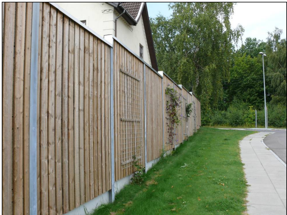
Figur 25. Træskærm med lavt prisniveau. Der er stor forskel på priserne for støjskærme. Denne type kan opføres for ca. 6.000 kr. pr. løbende meter (Karrebækvej, Næstved Kommune).
