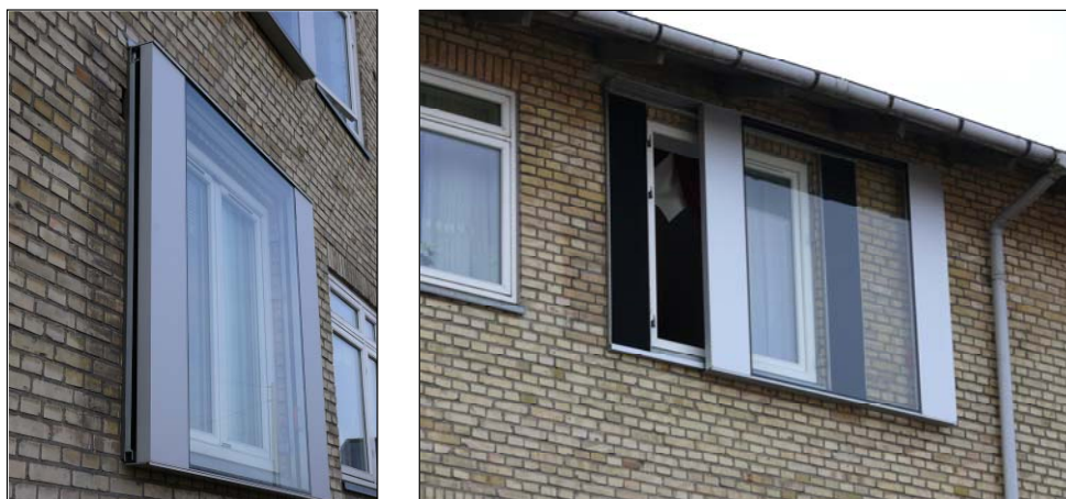
Figur 15. Lydskodde. Forsøgsprojektet om støjpartnerskaber omfattede bl.a. et projekt i Folehaven i København. Her blev der udvendigt på de eksisterende vinduer monteret en lydskodde, som gennem spalter i siderne tillader frisk luft at passere, mens støjen dæmpes. Skodden kan skyde til side, så vinduet kan åbnes helt.
