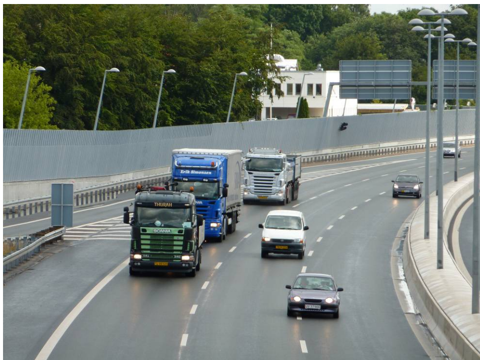
Figur 13. Støjskærme langs Motorring 3. Ved udvidelsen af Motorring 3 er der etableret støjskærme på hovedparten af strækningen og der er anvendt støjreducerende vejbelægning. Antallet af støjbelastede boliger er efter udvidelsen betydeligt lavere end før udvidelsen.
