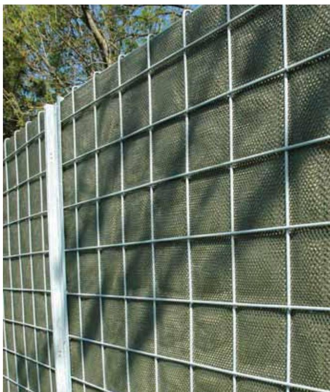
**Figur 17.** Støjskærme er ofte konstrueret med en overflade, der er porøs og derfor lydabsorberende. Det betyder, at støjskærmene ikke kaster støj over på den anden side af vejen. Ofte er det porøse materiale, som regel mineraluld, på siden mod vejen, dækket af en perforeret stålplade eller brædder med spalter. Når beklædningen på denne måde er åben, vil skærmen fortsat være lydabsorberende.
